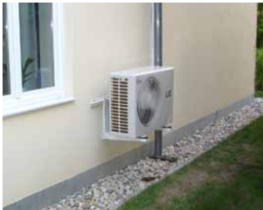
Single-Split Ausseneinheit 3,5kW
